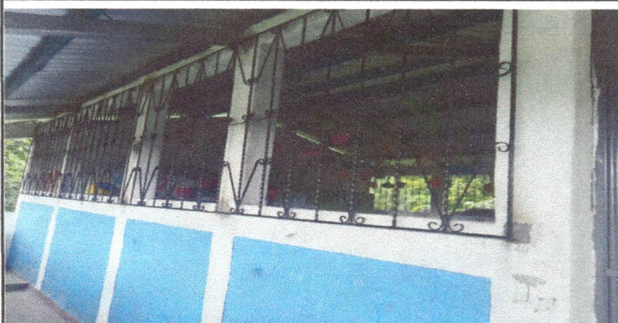
Foto 3: SUSTITUCIÓN DE BALCONES DE METAL.
