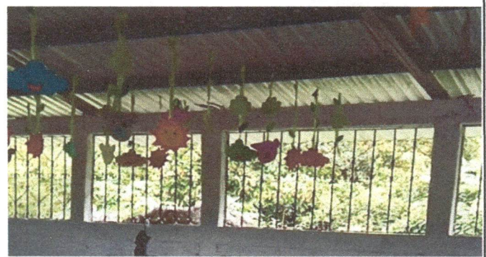
Foto 2: SUSTITUCIÓN DE BALCONES DE METAL.
