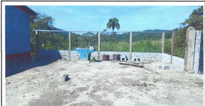
Foto 6: REPARACIÓN DE MURO PERIMETRAL DE BLOCK.
