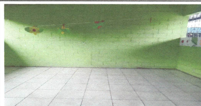
Foto 5: SUSTITUCIÓN DE TORTA DE CEMENTO POR PISO CERÁMICO.
